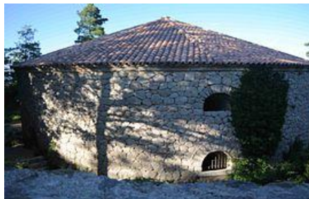
Glacière bâtie de Pivaut à Mazaugues (Var). Capacité de 3 000 m 3 de glace
